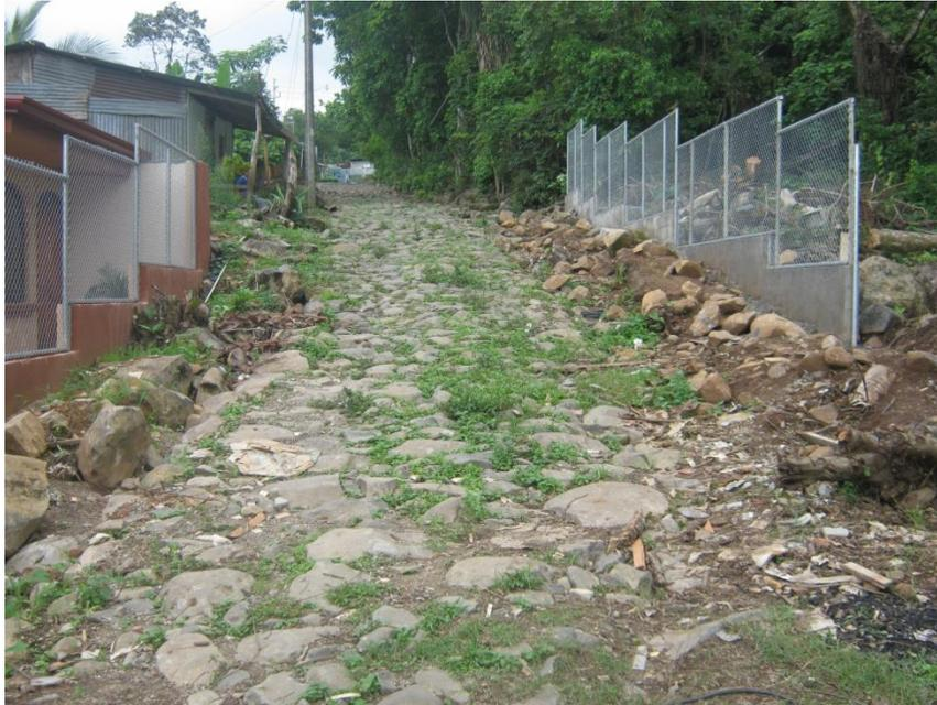
La calzada fue construida con cantaros rodados del río, tomados del mismo terreno, colocados estrechamente unos con otros, sin cantearlos detallada y linealmente. La calzada de piedra tiene una longitud de cien metros y un ancho de cuatro y medio de metros. El camino donde se ubica nace oblicuamente en la dirección sureste de la calle principal de Miramar.
