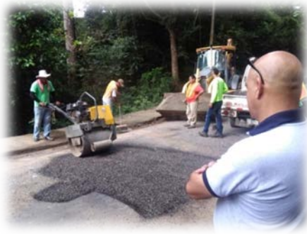
Limpieza localizada y bacheo localizado del camino 6-04-031(Secado Ecológico).
