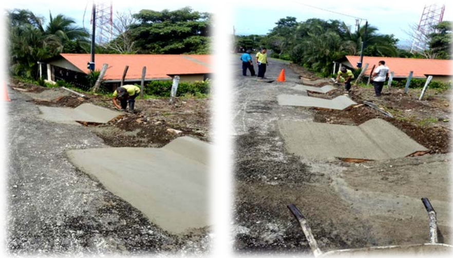
Limpieza, Reparación y/o construcción de Cunetas-Alcantarillas- Salidas de agua-
