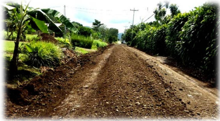
Limpieza localizada y bacheo localizado del camino 6-04-031(Secado Ecológico).
