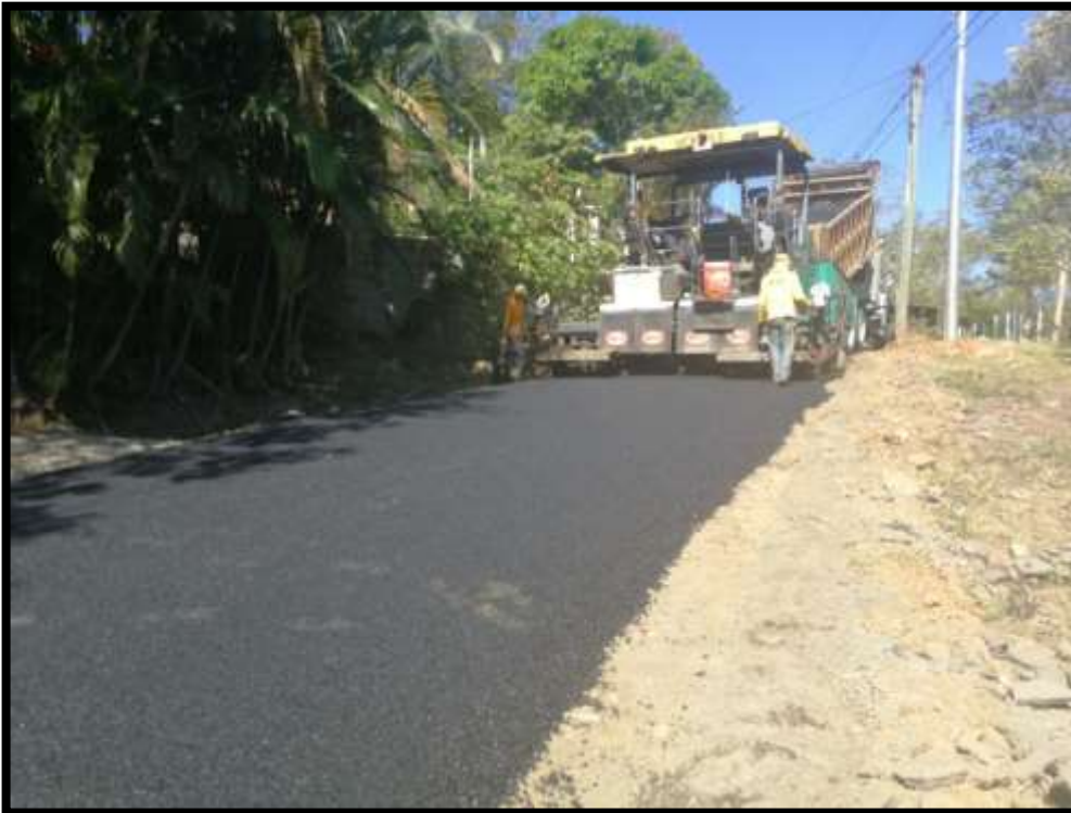
Asfaltado Las Huacas. Empresa MECO
