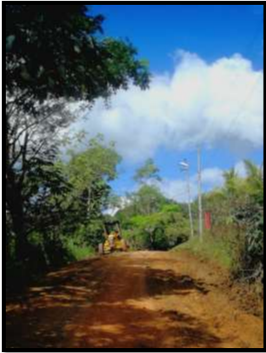
Construcción, Limpieza y conformación del camino hacia Sabana.
