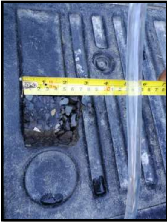
Pruebas de espesores de Asfaltado, cumpliendo al 100%
