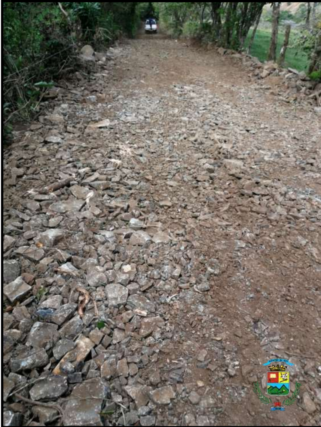
Limpieza y conformación del camino Las Pichingas.
