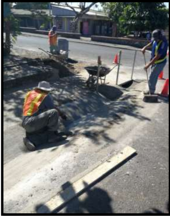
Construcción de Cunetas diagonal al Mercado Municipal
