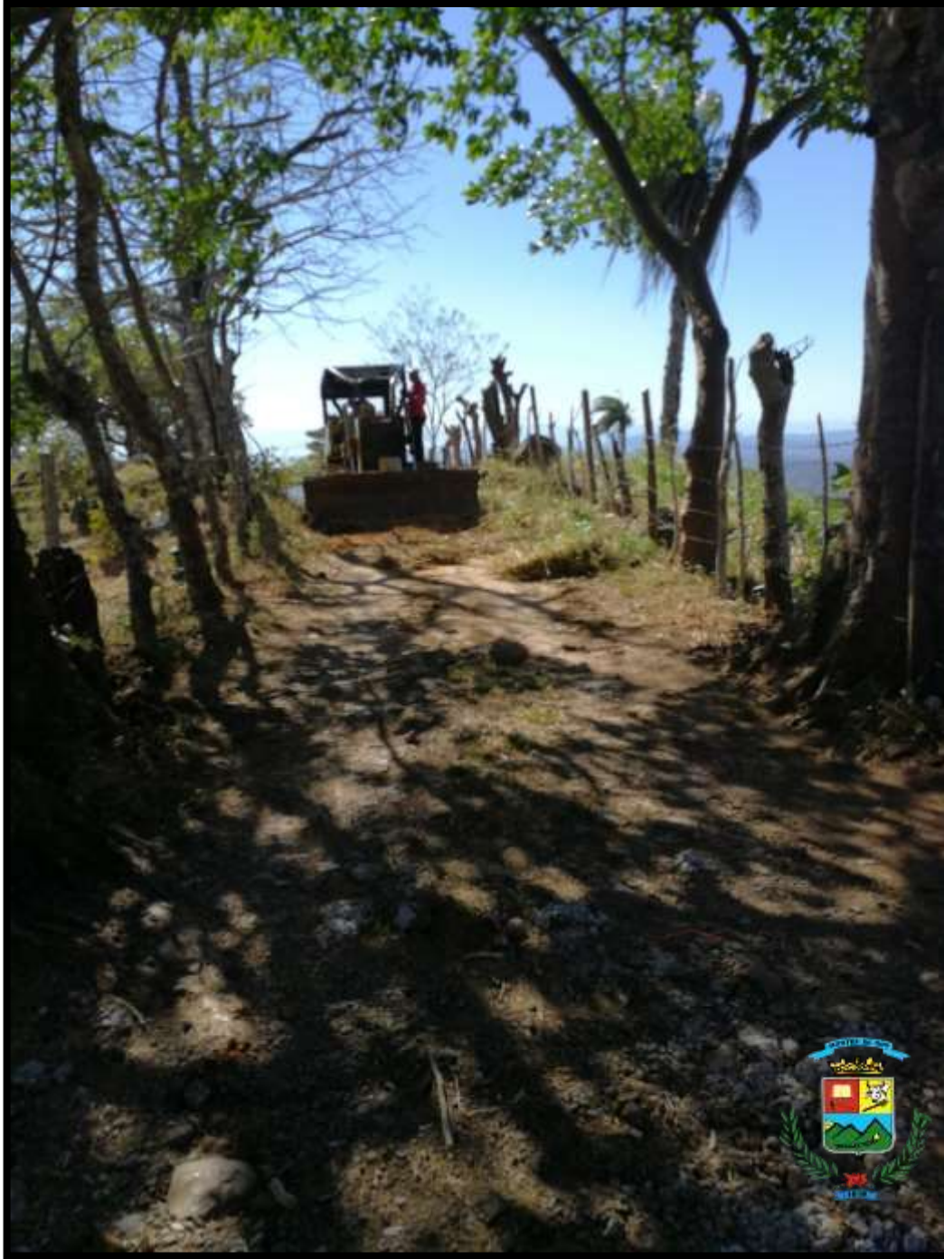
Limpieza y conformación del camino de Pavones. Diciembre-enero.
