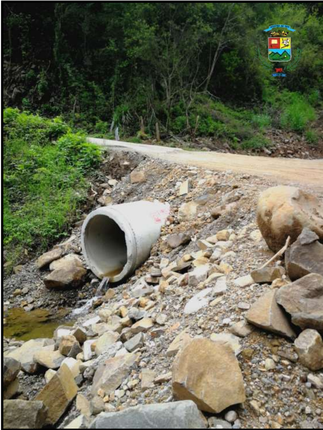
Colocación de paso de alcantarillado en Laguna con su respectivo cabezal.
