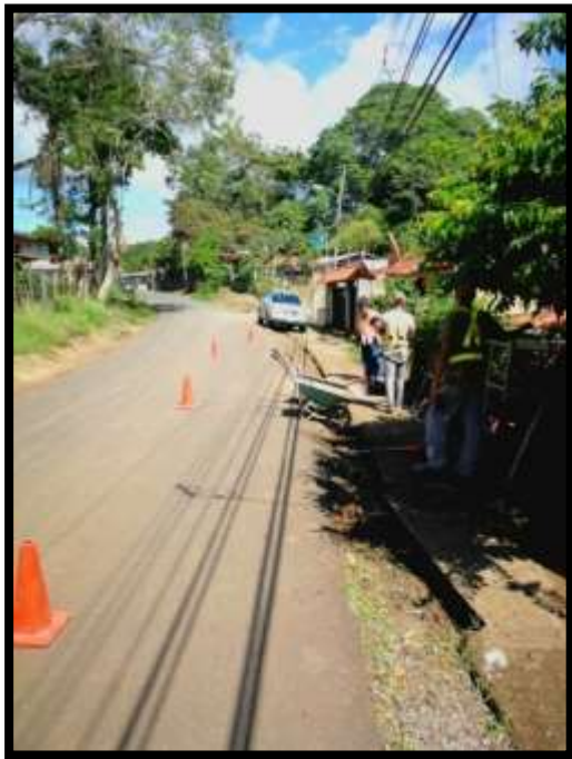
Construcción de Caja de Registro en San Isidro.
