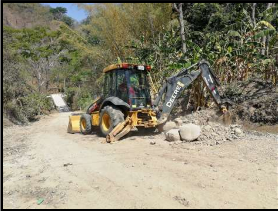
Construcción de cuesta concreto y asfaltado sobre el puente de Rio Seco
