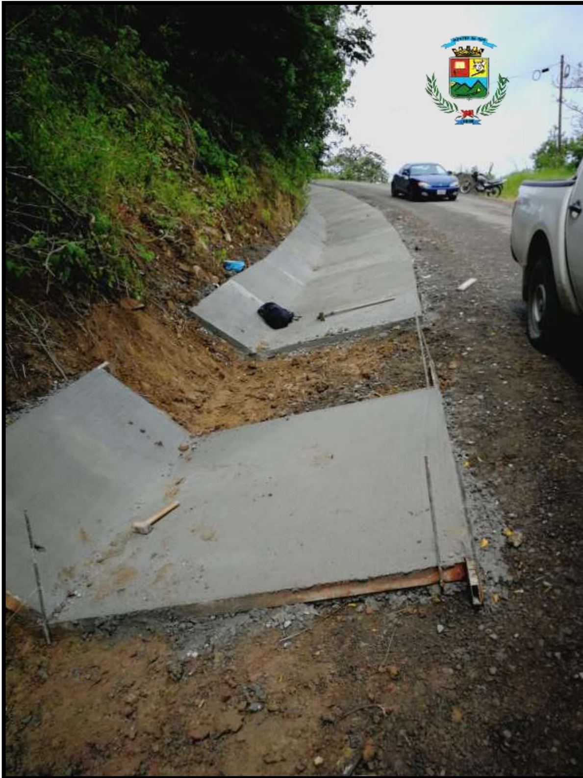
Construcción de Cunetas en Zona Norte
