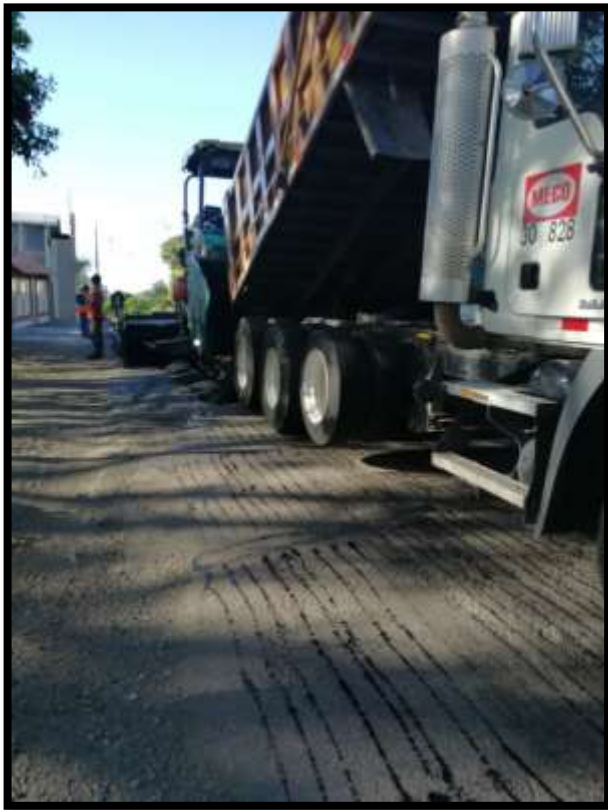
Asfaltado Calle Ronda. Empresa MECO
