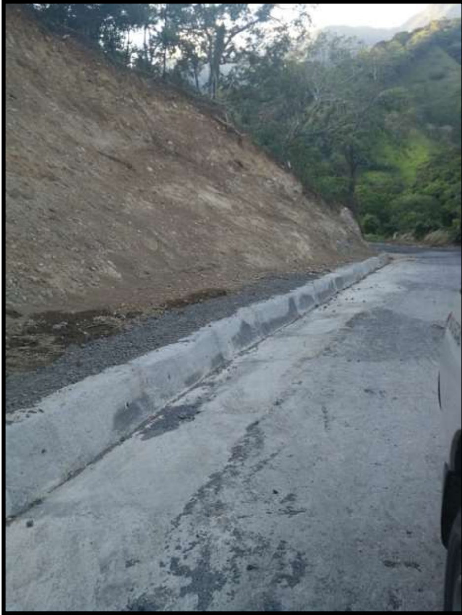
Construcción de Cunetas en Bajo Caliente.
