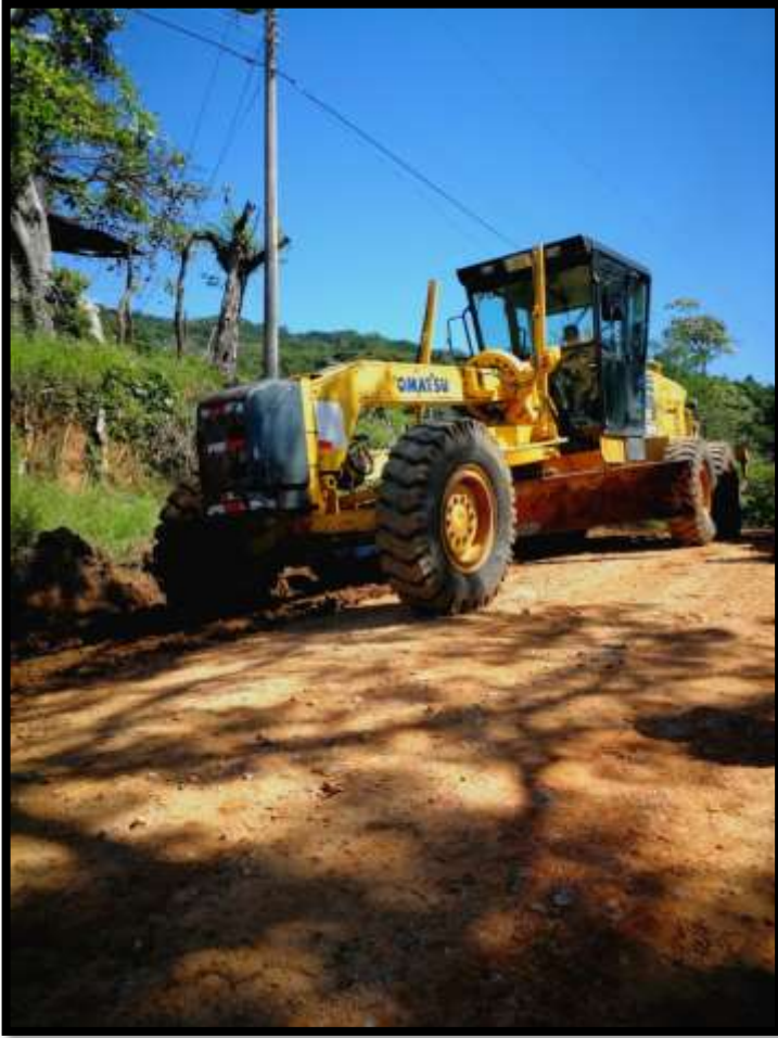
Construcción, Limpieza y conformación del camino hacia La Isla.
