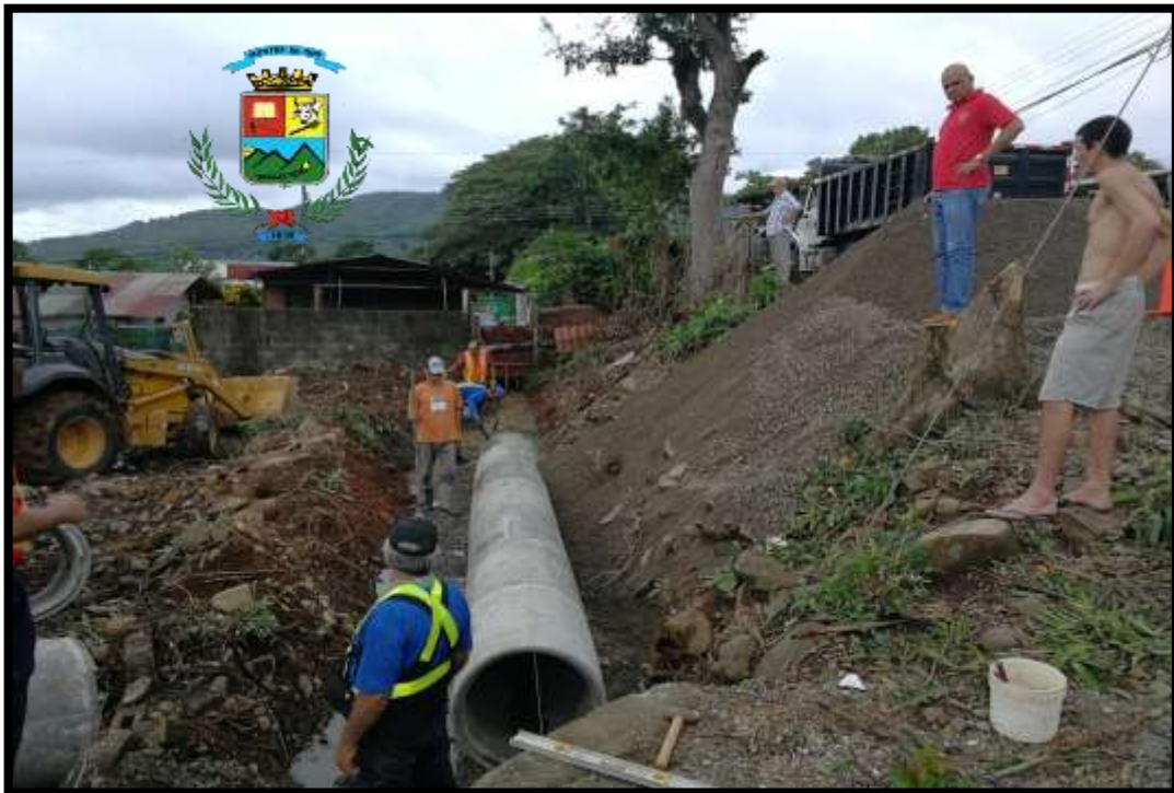
Colocación de paso de Alcantarillado por donde Doña Guillermina.
