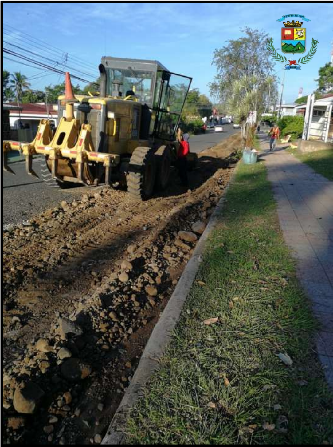
Construcción de espaldón frente al Edificio Municipal.
