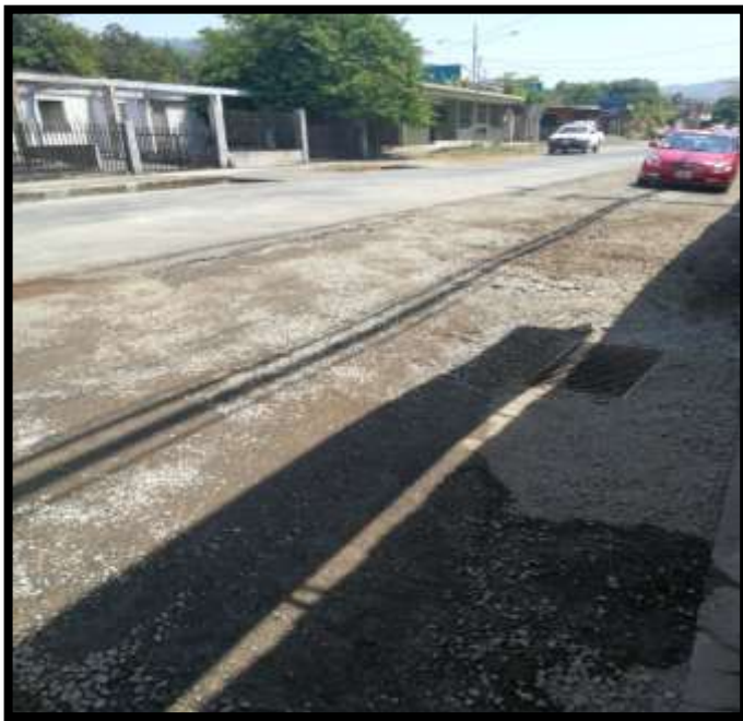
Limpieza, conformación de espaldón de antigua Clínica de Miramar
