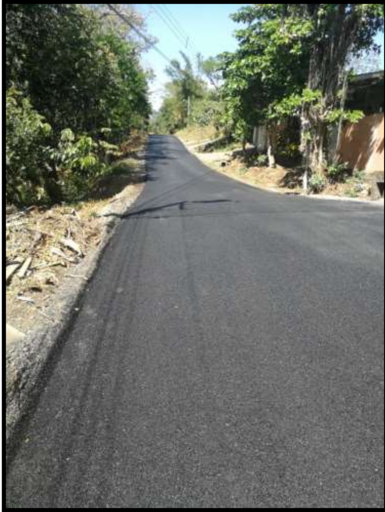
Asfaltado Calle Ronda. Empresa MECO
