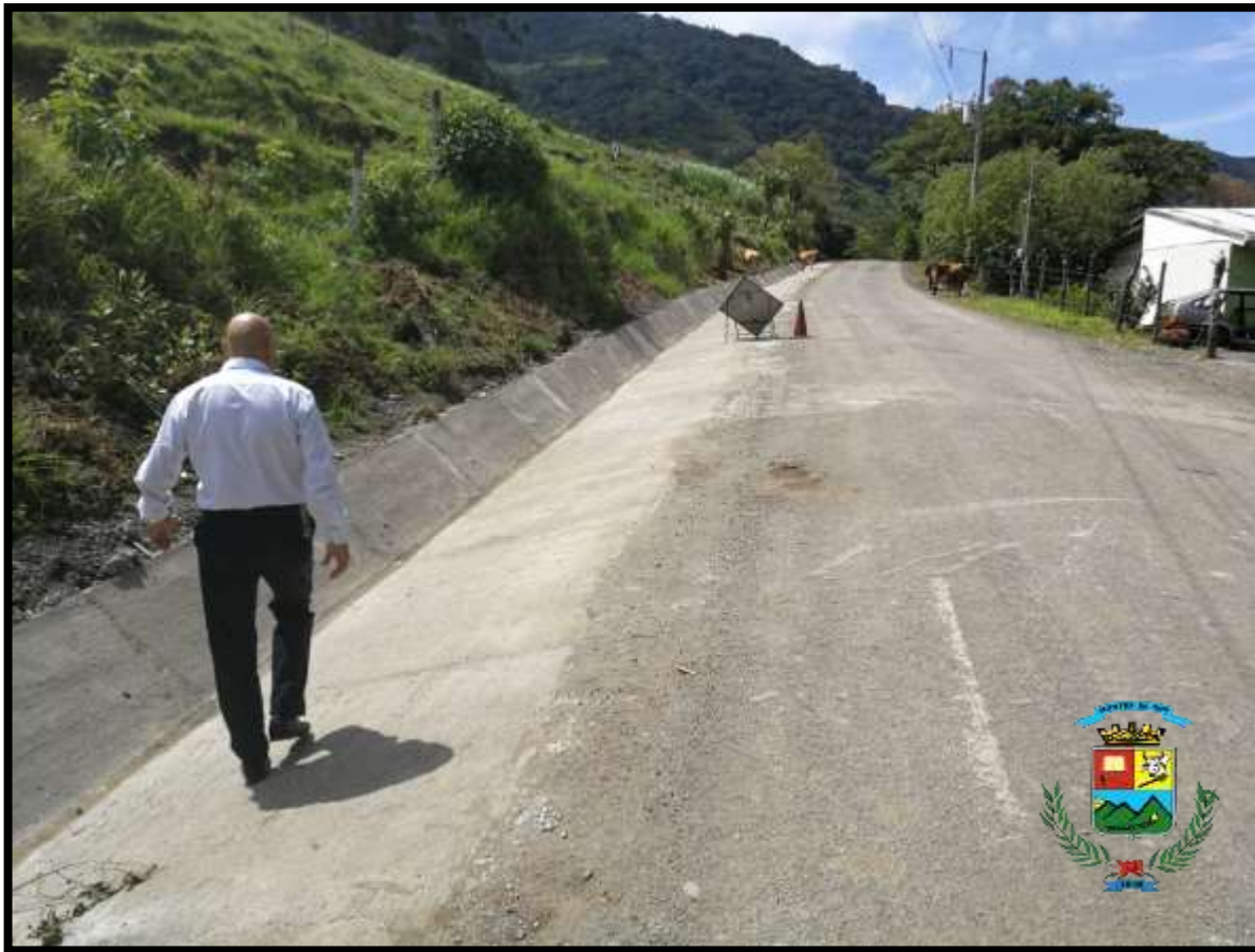
Construcción de cuneta en Palmital, Distrito La Unión.
