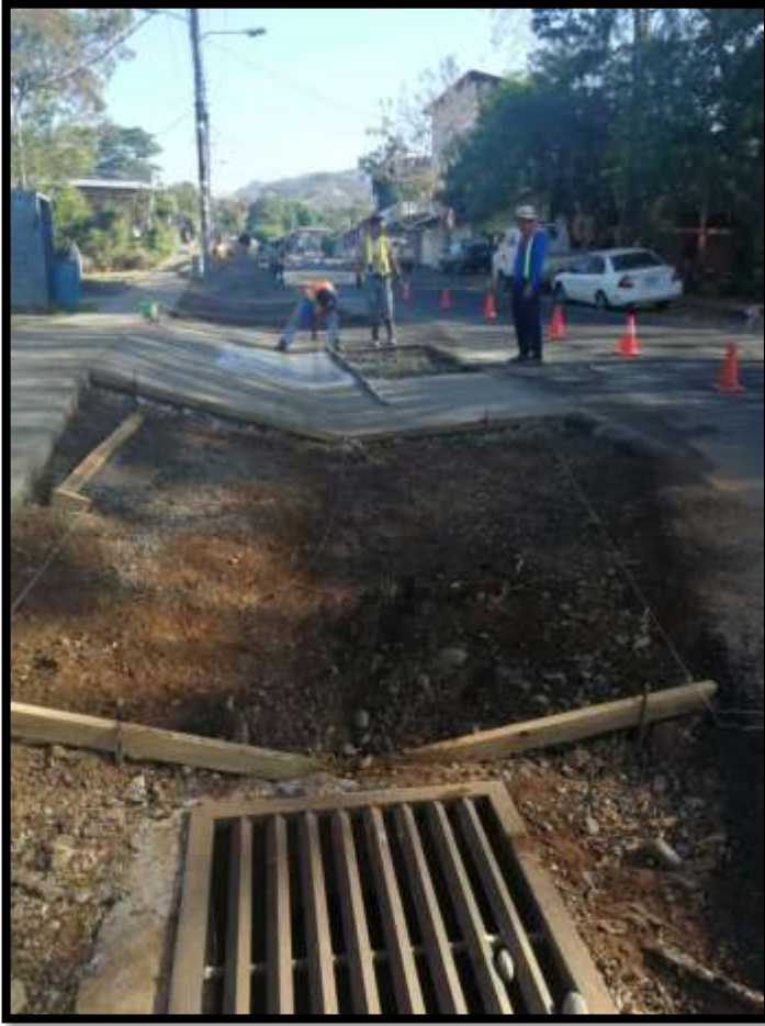
Construcción de cunetas frente a la estación de Policía de Miramar
