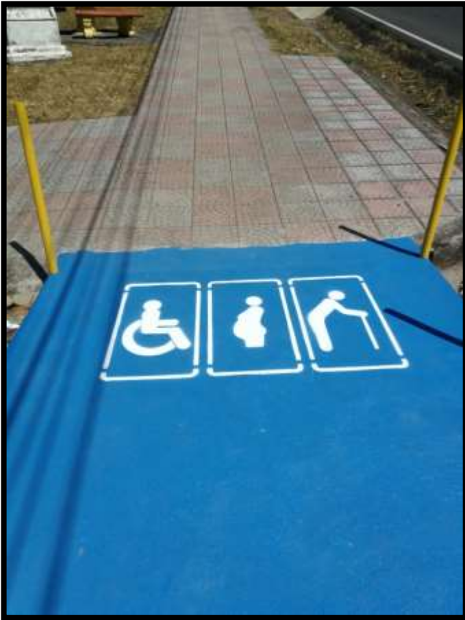
Construcción de rampas, conforme a la Ley 7600
