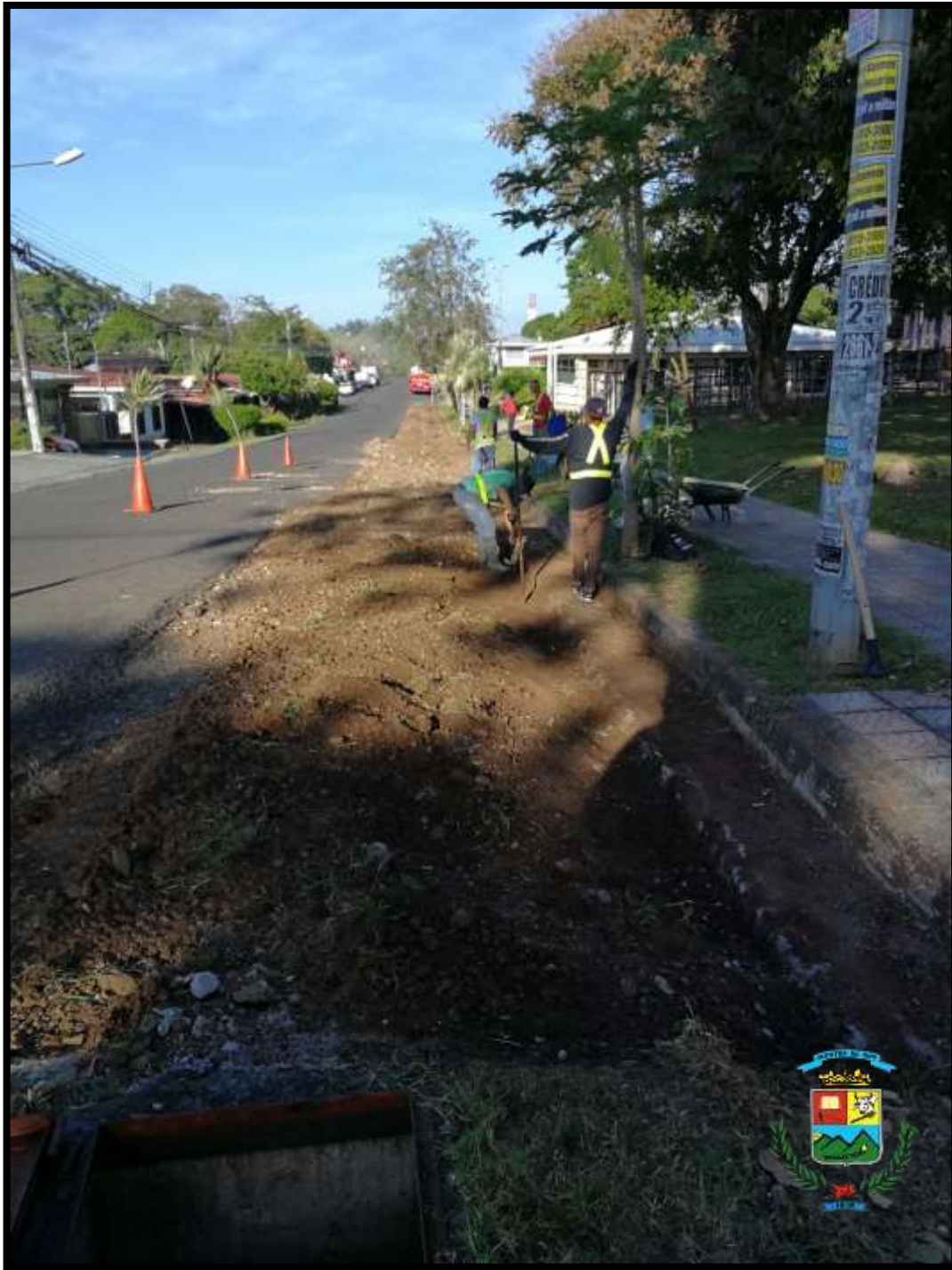
Construcción de espaldón frente al Edificio Municipal.
