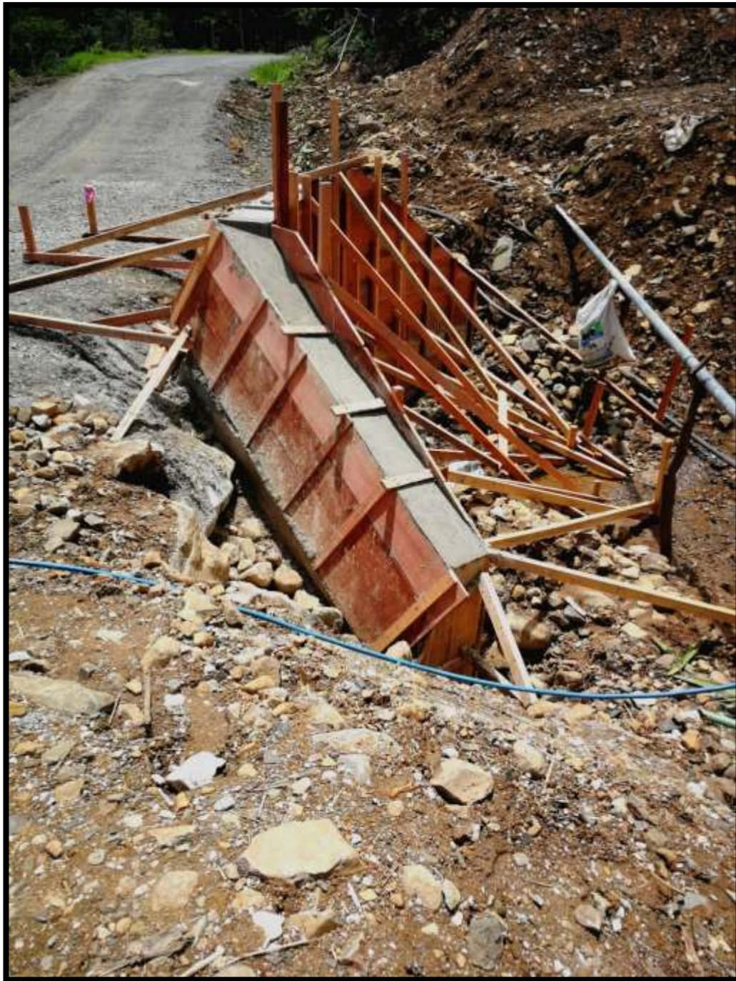
Construcción de Cabezales
