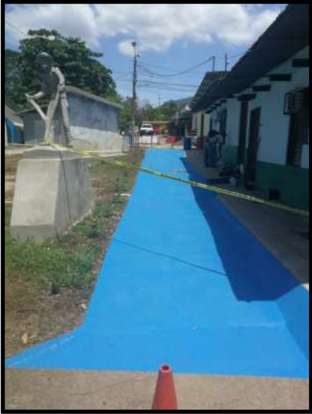
Construcción de Acera Ley 7600 en el Parque Minero.
