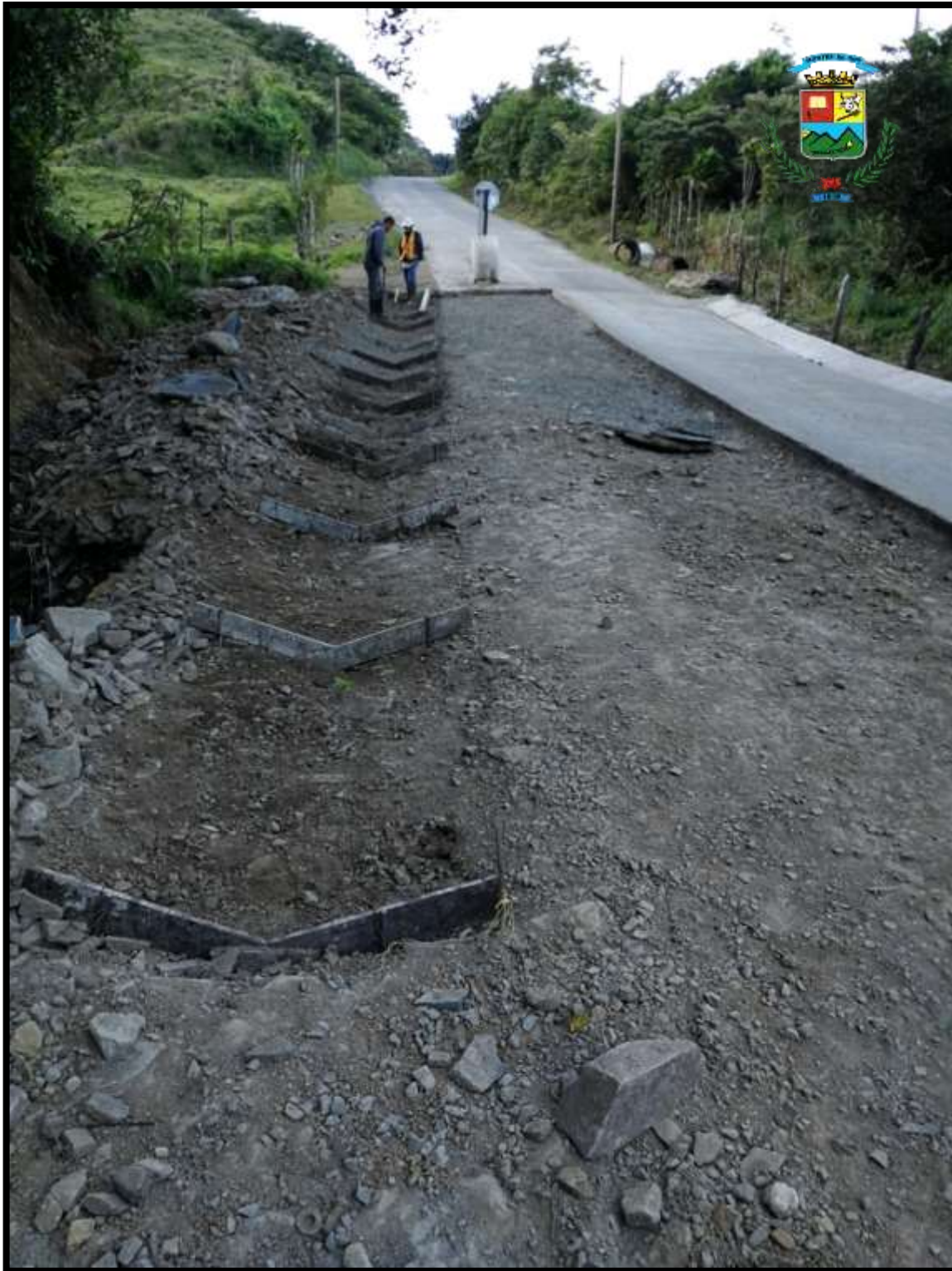
Construcción de cuesta en concreto en Zapotal.
