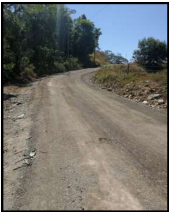
Limpieza conformación, del camino Las Huacas hacia La Isla.
