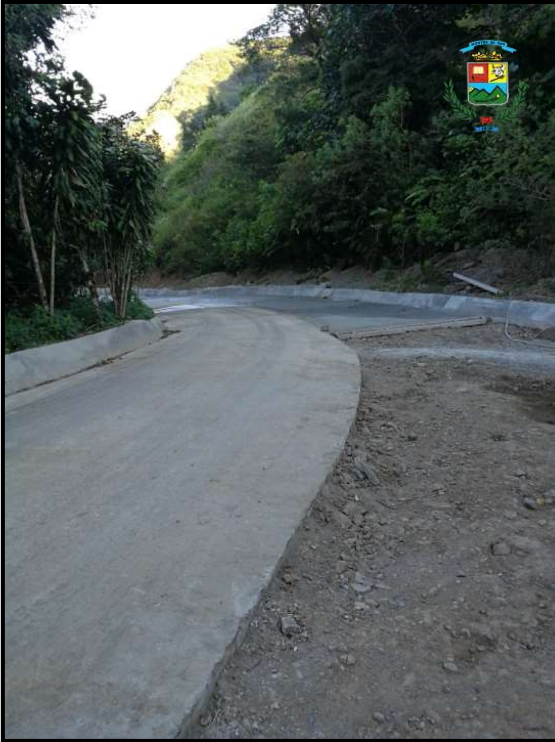
Construcción de cuesta y cuentas en concreto en Zapotal.
