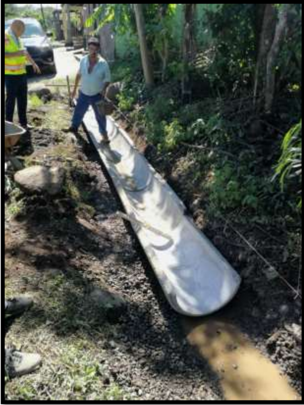
Colocación de medias cunetas en San Isidro.
