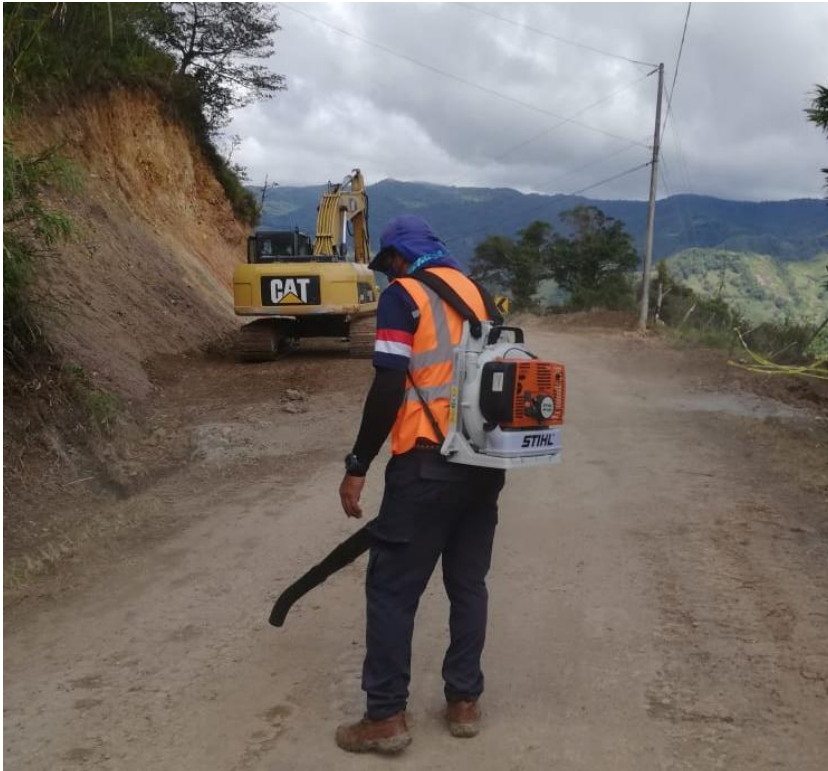
Trabajos en Cedral.
