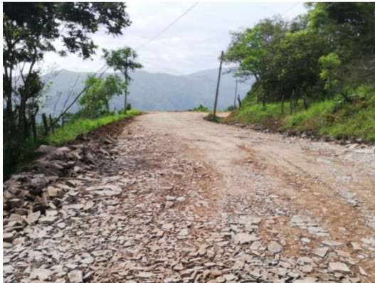
Mantenimiento rutinario, Bajo Caliente.
