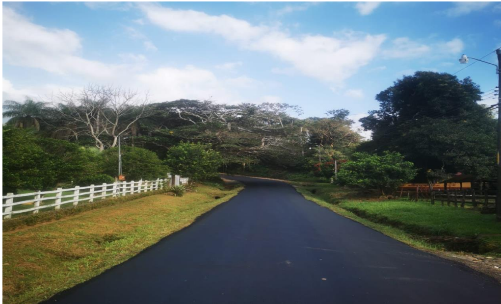
Asfaltado Rio Seco
