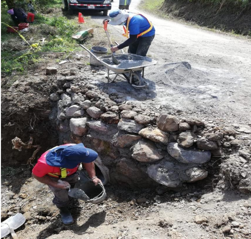
Trabajos, colocación de paso de Alcantarillado, en Cedral
