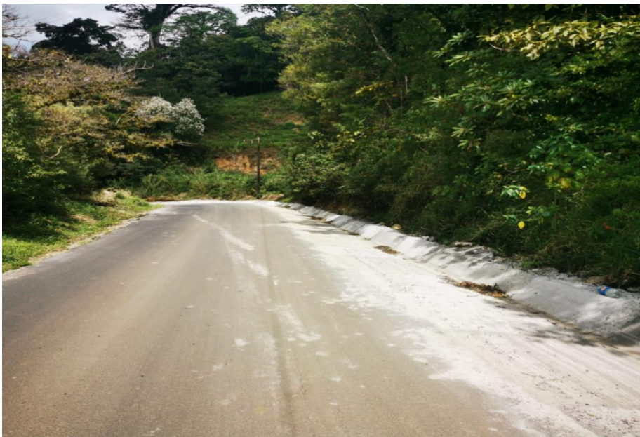
Trabajos de cunetas en Zapotal.
