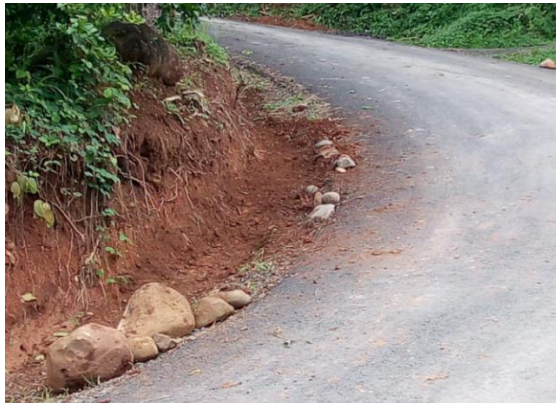
Limpeza Cunetas La Isla.
