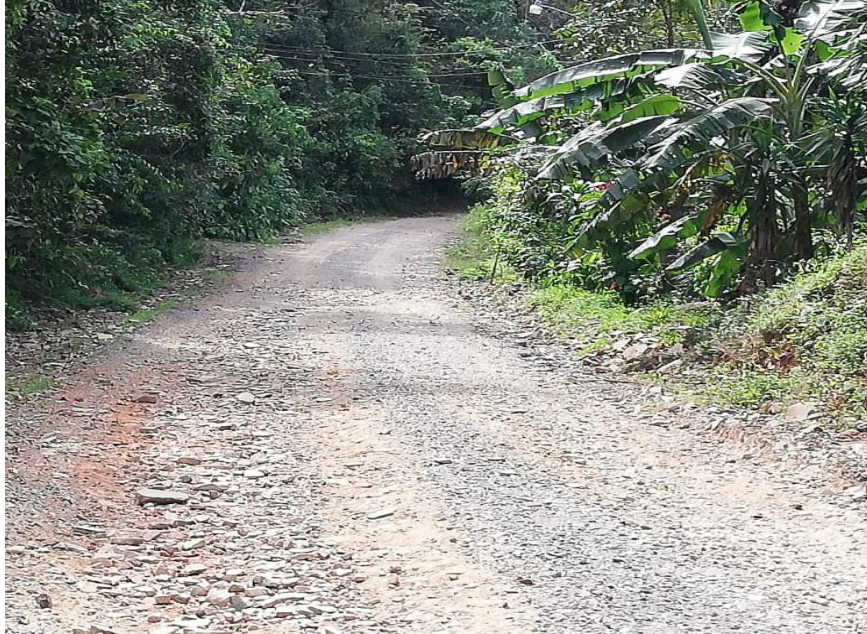
Trabajo Pavones, colocación de material de lastre.
