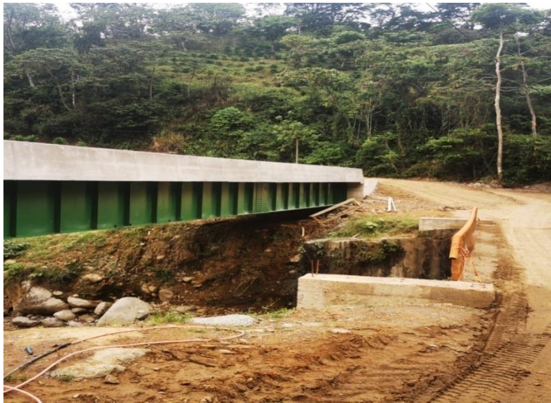
Construcción Puente San Francisco Cedral. Convenio Municipalidad de Puntarenas y Municipalidad de Montes de Oro.
