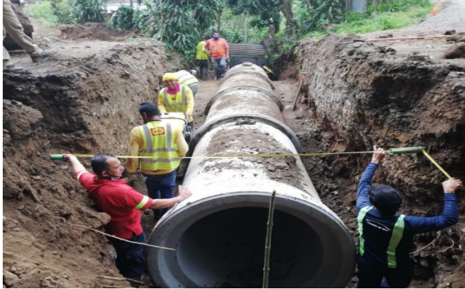
Colocación de tubería de concreto, Manejo de pasos pluviales.
