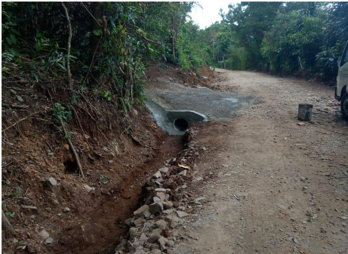
Trabajo, mantenimiento Camino Pavones, limpieza y conformación de la vía.
