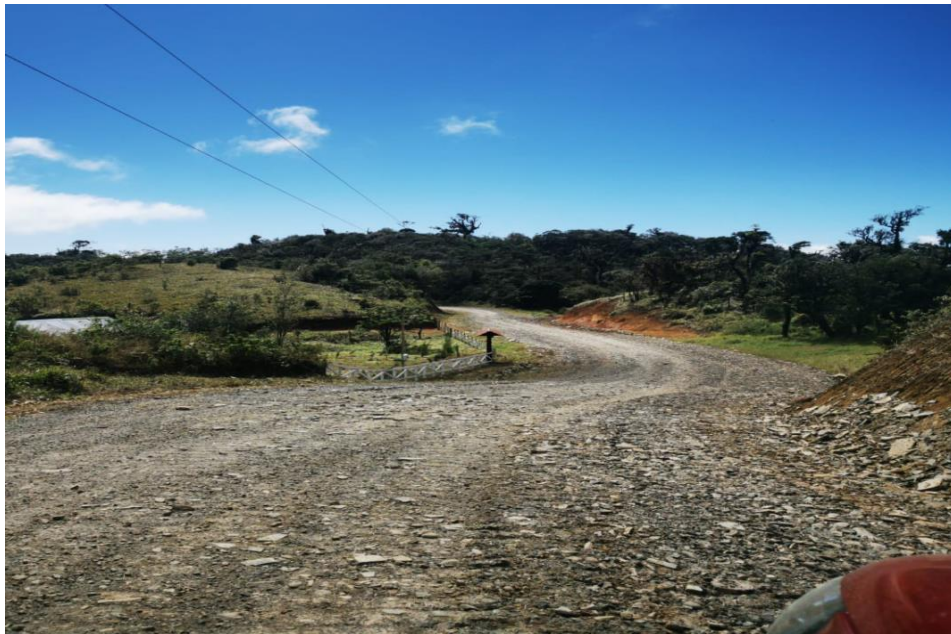
Trabajos en camino Zapotal.
