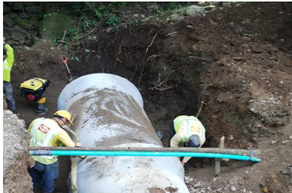
Inicios de Trabajos MOPT-BID Tajo Alto-La Unión.
