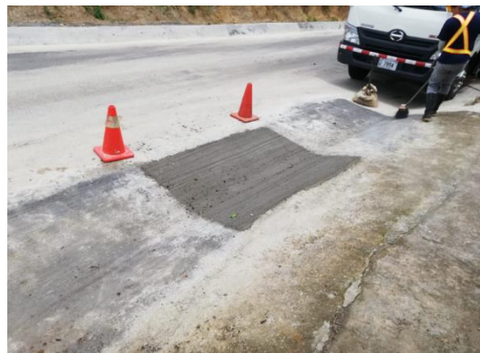
Construcción de Cunetas, en camino hacia Sabana, por la quebrada El Ángel.
