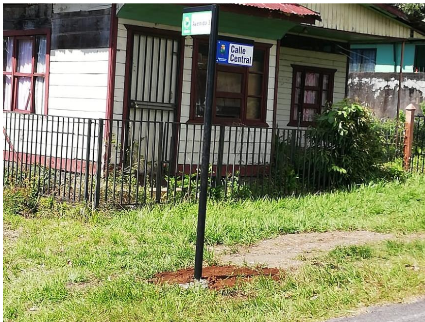
Colocación de señales verticales, calles y avenidas.
