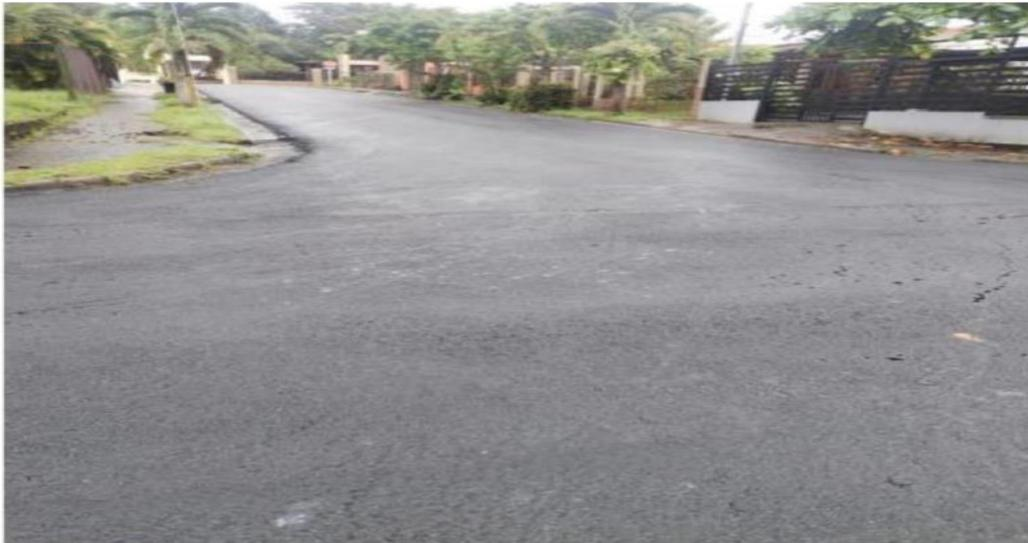
**Superficie o capa de rodamiento nueva con mezcla asfáltica en caliente**
